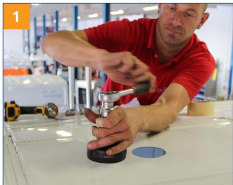
Markieren Sie die Löcher mit der mitgelieferten Bohrschablone und stanzen Sie mit einer 90 mm-Stanze (auf Anfrage erhältlich) die Löcher in das Dach.
